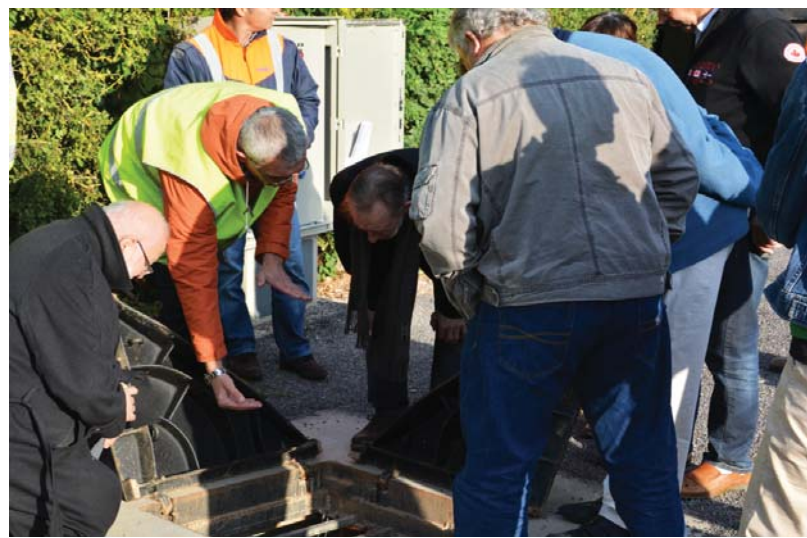
Réception des travaux de création du réseau d'assainissement collectif à Sai.
