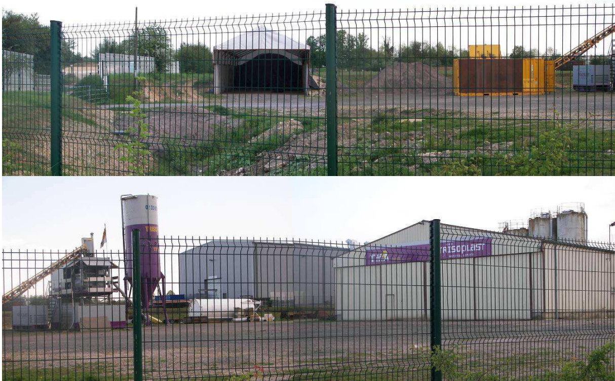
Le dépôt et le bâtiment de l'entreprise Trisoplast
