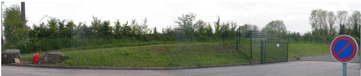
Vue sur la limite Nord du terrain projet de l'extension, avec au 1er plan, l'entrée dans l'enceinte des Verreries de l'Orne longée par le chemin agricole
