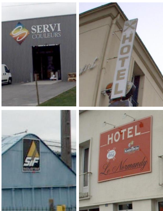
Exemple de dispositifs muraux posés à plat recensés sur la communauté de communes
