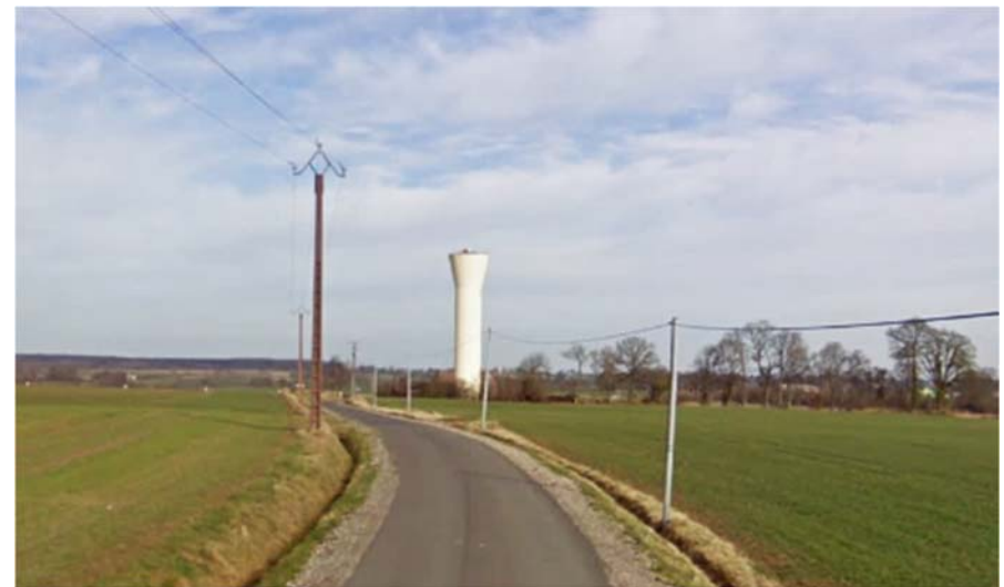
Château d'eau à Boucé
