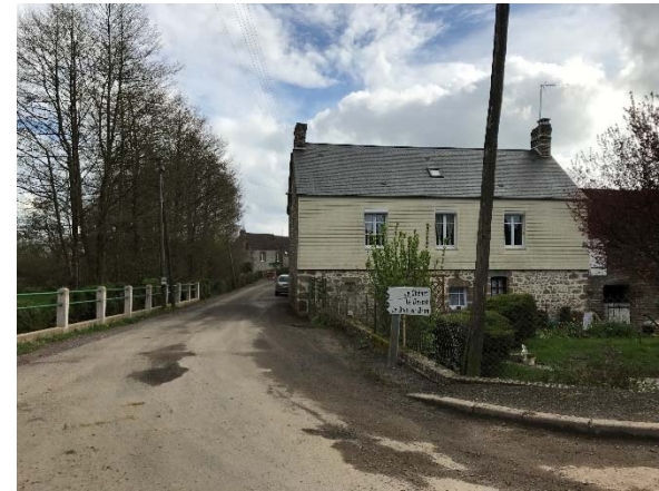
Photo d'un bâtiment isolé par l'extérieur partiellement à Vieux-Pont
