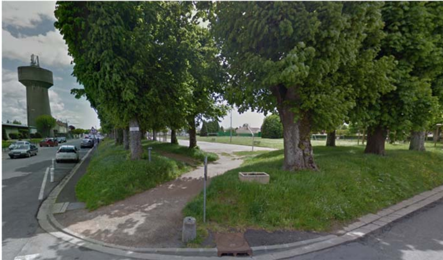
Monument aux morts et double alignement de tilleuls
