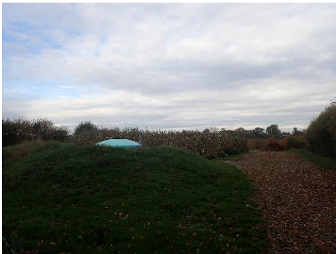
Photo 6 : Station d'épuration de Vieux-Pont
