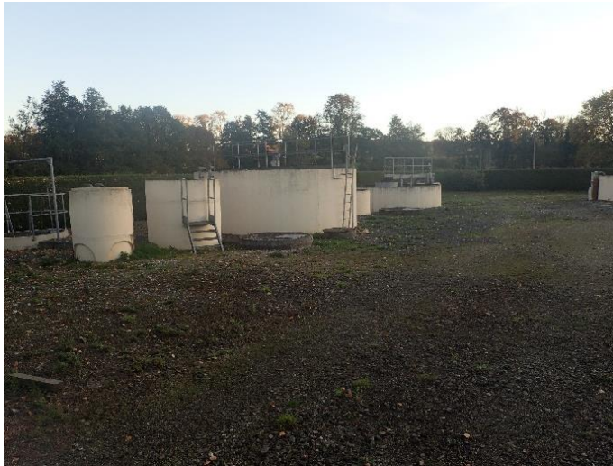
Photo 5 : Station d'épuration de Lougé-sur-Maire
