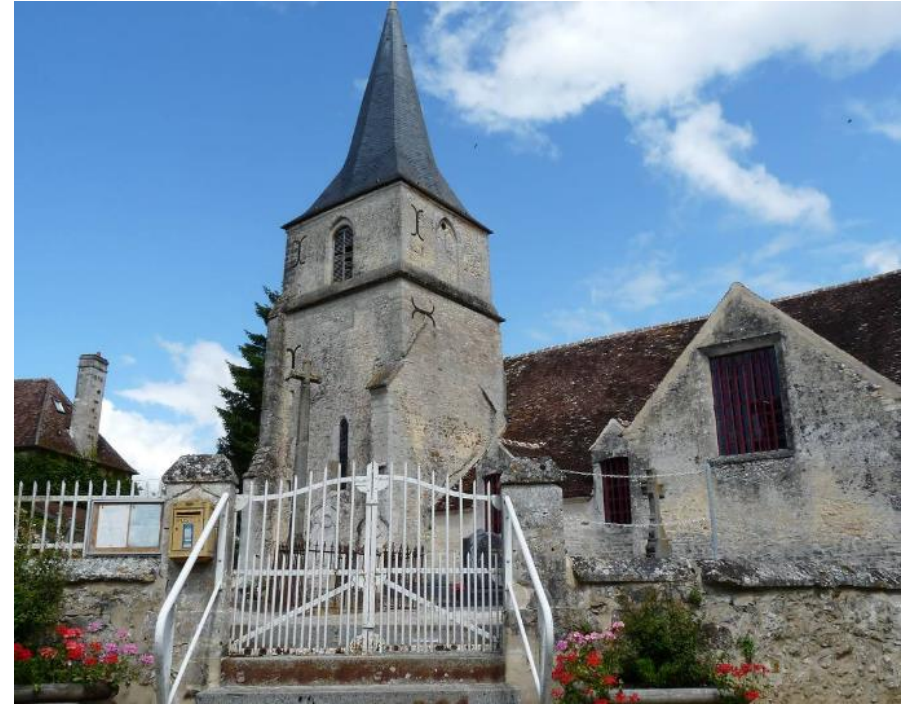
Eglise de Loucé
