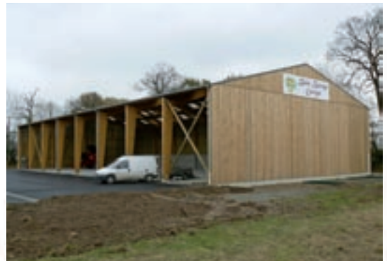
La plate-forme de la société Bois Bocage Energie
