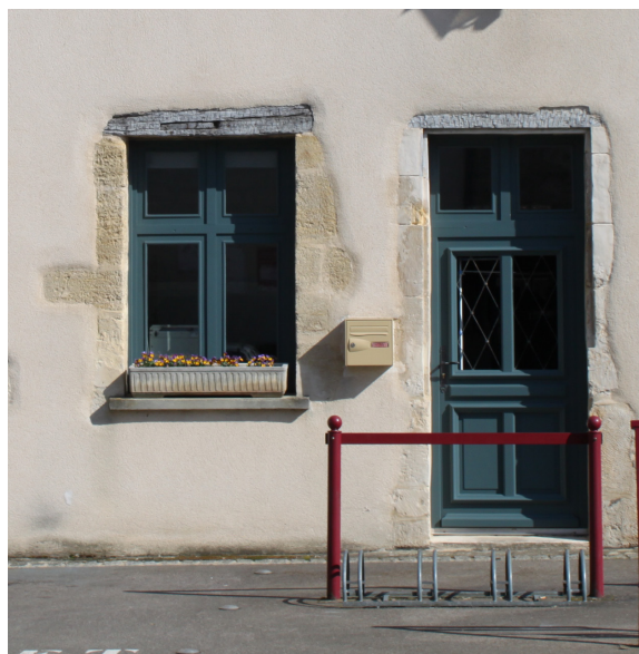
Remplacement des menuiseries.
