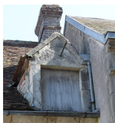
Lucarnes à pignon
