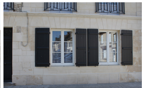
Les bâtiments du centre d'Ecouché sont construits majoritairement en moellons de calcaire. Ce matériau peu résistant au gel nécessite la protection d'un enduit. Les éléments de modénature (encadrement de baies, corniches, bandeaux) en pierre de taille restent apparents. Quelques maisons sont réalisées en pierre de taille.
