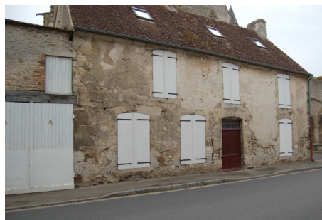
Les bâtiments du centre d'Ecouché sont construits majoritairement en moellons de calcaire. Ce matériau peu résistant au gel nécessite la protection d'un enduit. Les éléments de modénature (encadrement de baies, corniches, bandeaux) en pierre de taille restent apparents. Quelques maisons sont réalisées en pierre de taille.
