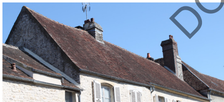
Toit à deux versants
