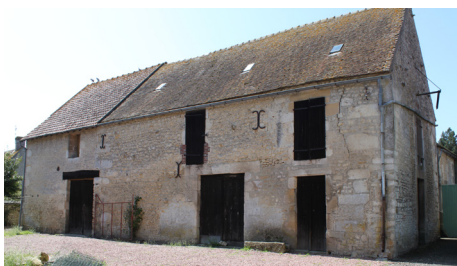
Dépendance : absence de symétrie en façade, dominance des pleins sur les vides
