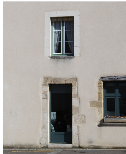
Création d'une fenêtre à l'étage
