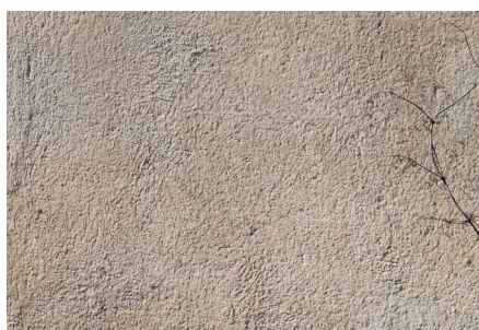
Enduit «plein» : les murs sont enduits sur toute leur surface
