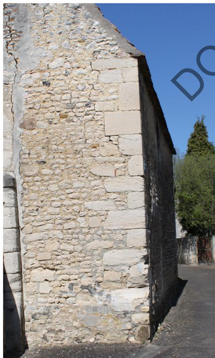
La pierre de taille est utilisée pour les modénatures (encadrement de baies, corniches, bandeaux, chaînes d'angle.)
