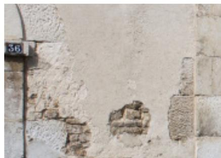
Enduit plein dégradé : des traces d'enduit souvent préservées dans les zones protégées sous la corniche par exemple indiquent le type d'enduit d'origine
