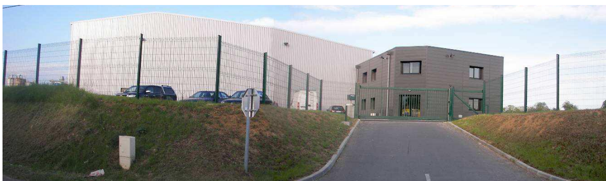
L'entrée de l'établissement Roger depuis la RD 29
