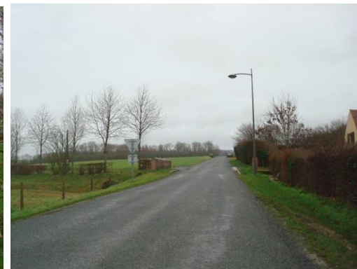
Accès RD 752 depuis le vallon du ruisseau de la Tricoire
