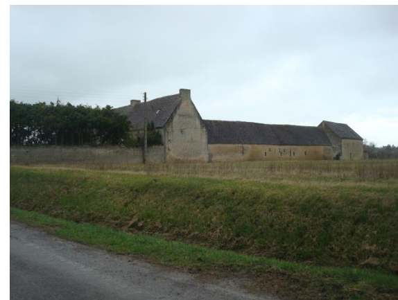
La Grand Cour en limite du site le long de la RD 238
