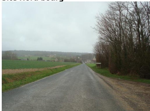
Vue lointaine sur le site depuis la RD 752
