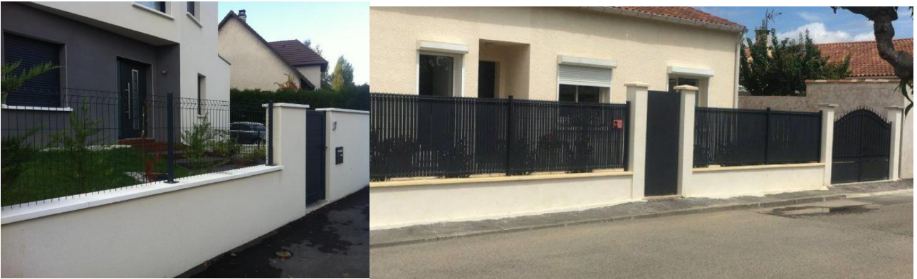
Clôtures constituées d'une grille/grillage ajouré sur un mur bahut
