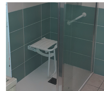
Adaptation d'une salle de bains en salle de douche avec siège de douche et barre d'appui
