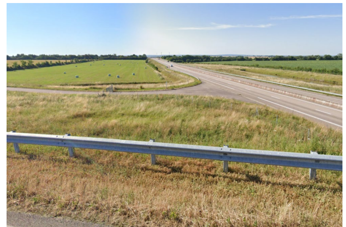
Moulins-sur-Orne. Source : Google 2019.
