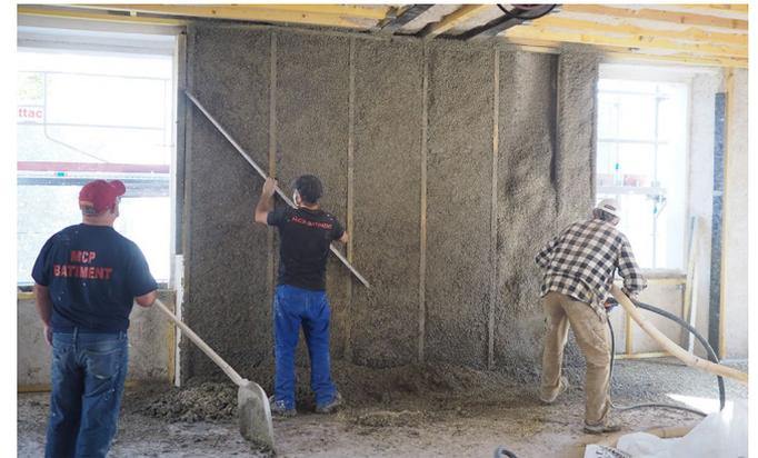
*Isolation intérieure d'un bâtiment au béton de chanvre, Dumont Legrand Architectes*
