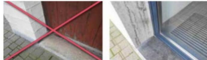
Exemple d'adaptation du bâti : A gauche, éviter les seuils afin de faciliter l'évacuation des eaux et des boues / A droite, type de menuiseries à privilégier pour une meilleure résistance aux pressions de l'eau (Source : Guide Bâtiment Durable Bruxelles)
