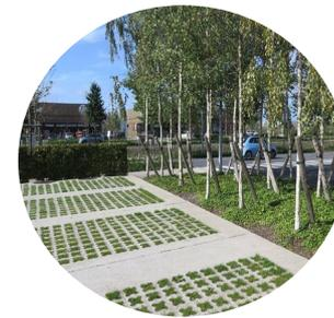
Exemple de parking semi-perméable
