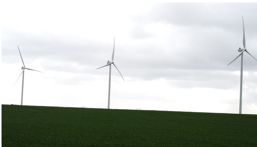
Des éoliennes sur le territoire de Terres d'Argentan Interco Source : IETI
