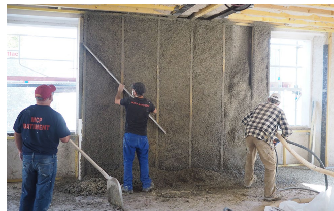
Isolation intérieure d'un bâtiment au béton de chanvre, Dumont Legrand Architectes
