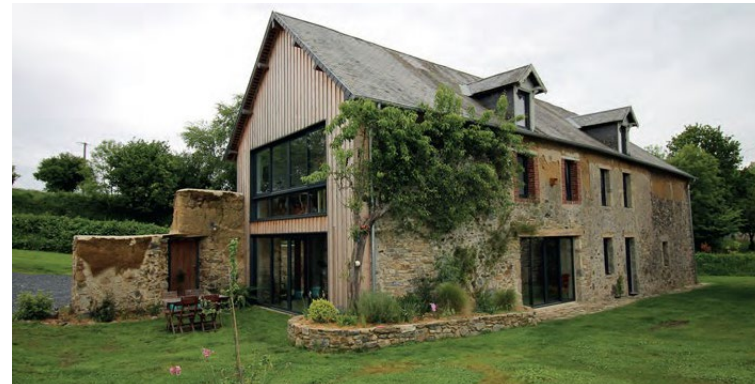
Les modifications se concentrent sur le pignon pour préserver la façade principale. Edouard Grisèle, Cambernon (50), 2015
