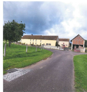
Parcelle n° 08 0950 Adresse 4 Rue de la Source Commune COULONCES Département MAYENNE
