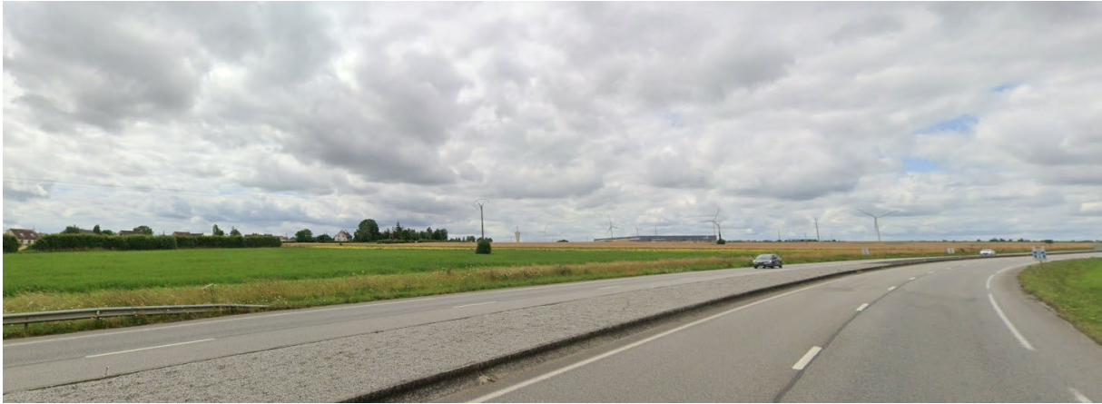
Vues du secteur depuis la route
