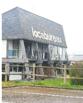
Enseigne sur toiture
