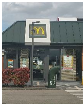
Enseigne sur toiture
