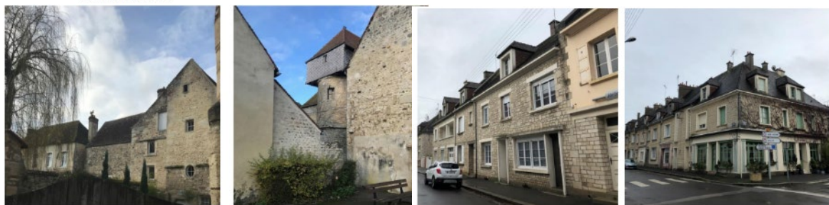
Exemples de bâtiments identifiés et protégés par le biais de prescriptions/préconisations particulières : ici les « maisons tours » (2 photos de gauche) et le patrimoine de la Reconstruction (2 photos de droite)
